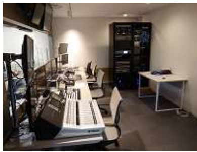
オペレーター室
